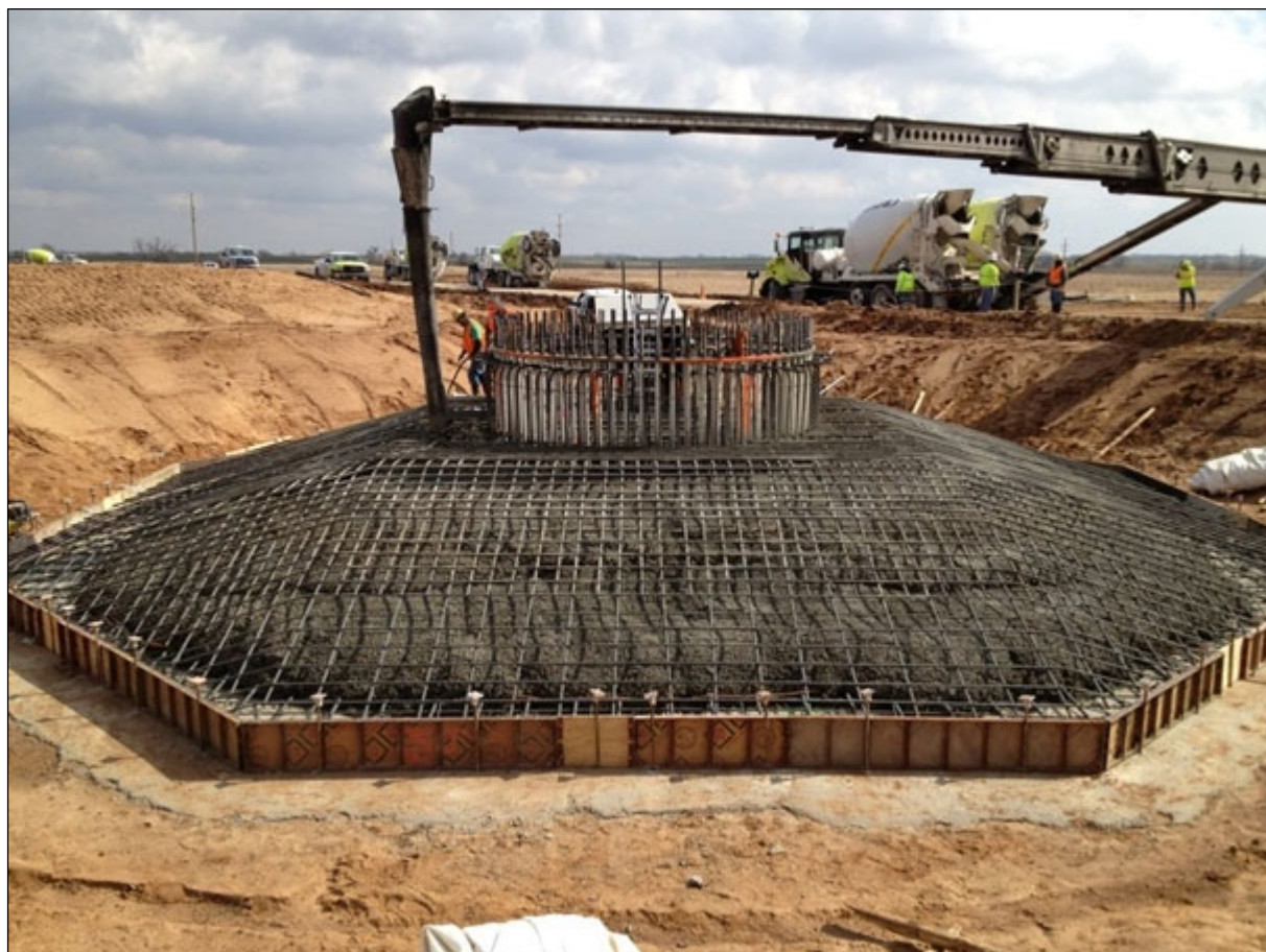
Obrázok 8: Teleso základov veternej elektrárne z armovaného betónu
