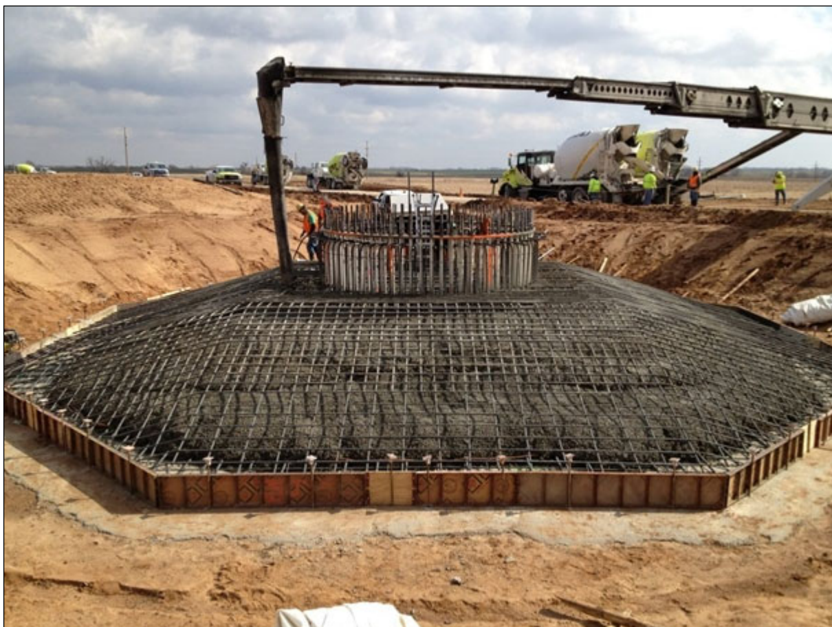
Obrázok 8: Teleso základov veternej elektrárne z armovaného betónu
