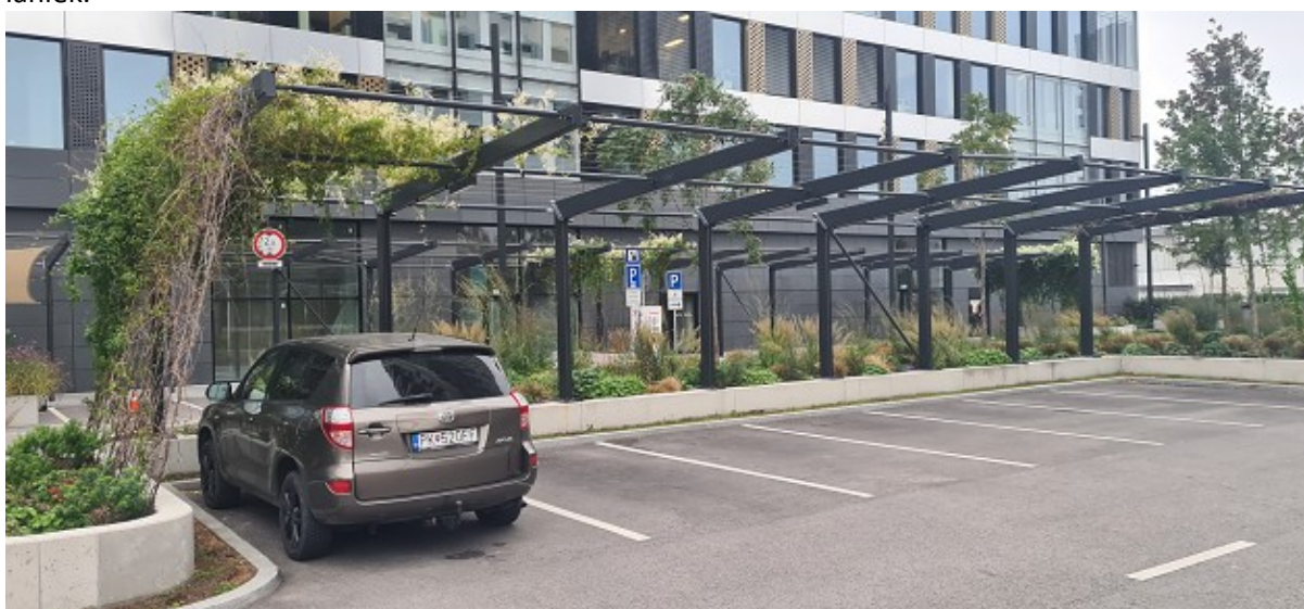
Parkovacie státa samotné prekryť popínavými rastlinami na nosných konštrukciách z oceľových laniek.
