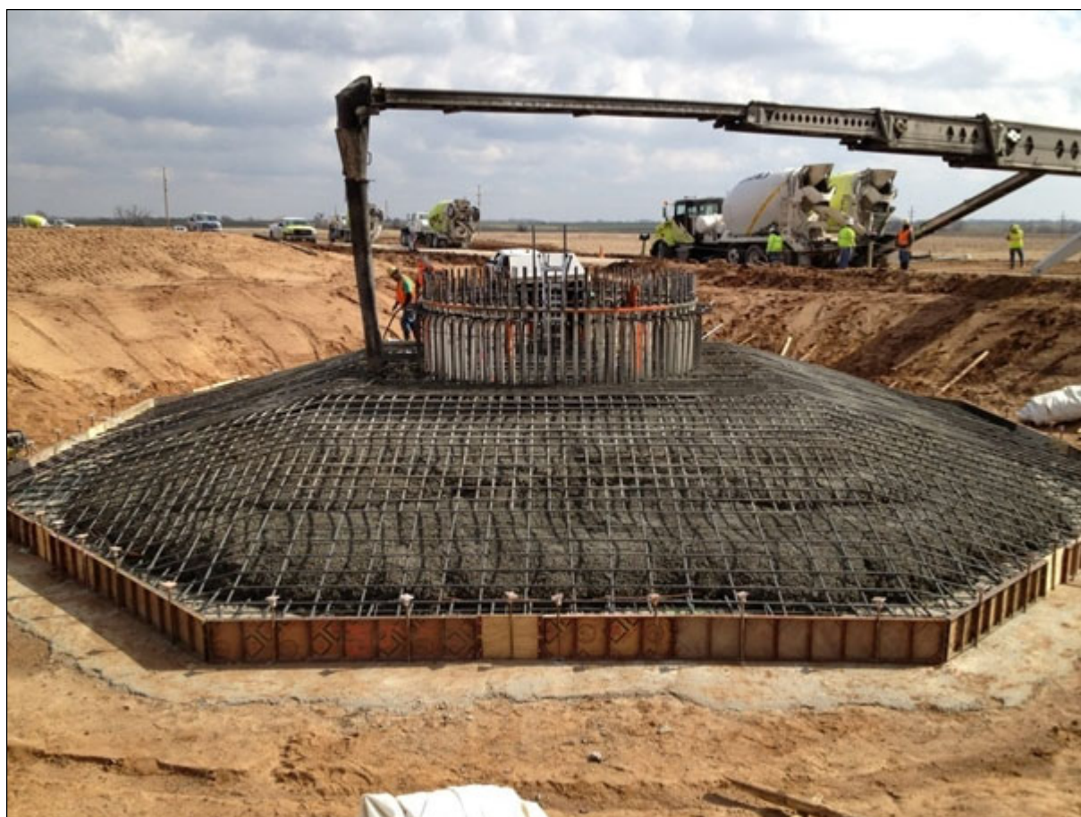
Obrázok 8: Teleso základov veterných elektrární z armovaného betónu
