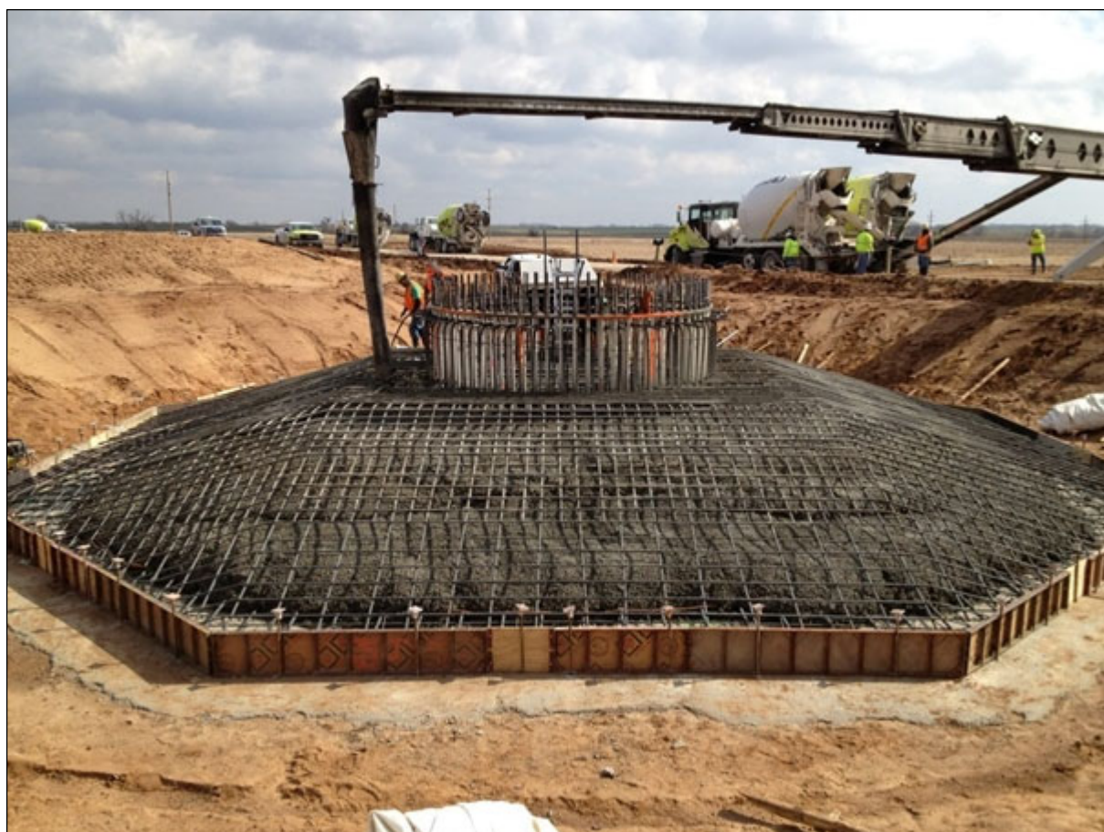
Obrázok 8: Teleso základov veternej elektrárne z armovaného betónu
