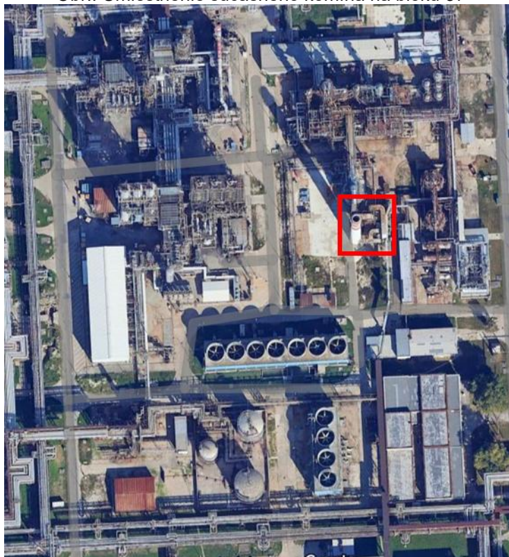
Obr.: Umiestnenie súčasného komína na bloku 57
