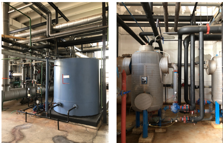
Obrázok 5 Úpravovne systémovej vody - Galantaterm
