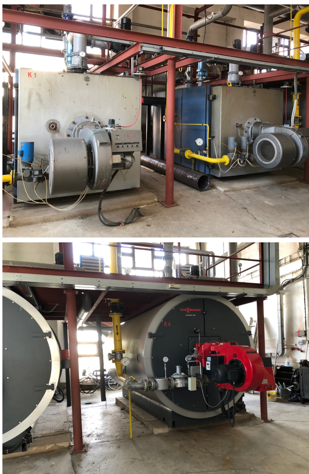
Obrázok 4 Záložný zdroj, plynová kotolňa - Galantaterm
