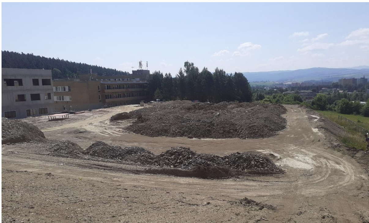
Foto 1 Pohľad na lokalitu nového heliportu zo severu, vľavo realizované modernizačné práce
