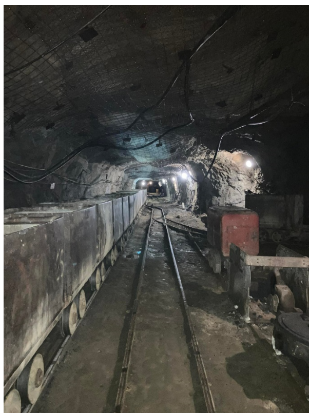
Foto č. 13: Doprava vozíkovým obehom – v podzemí
