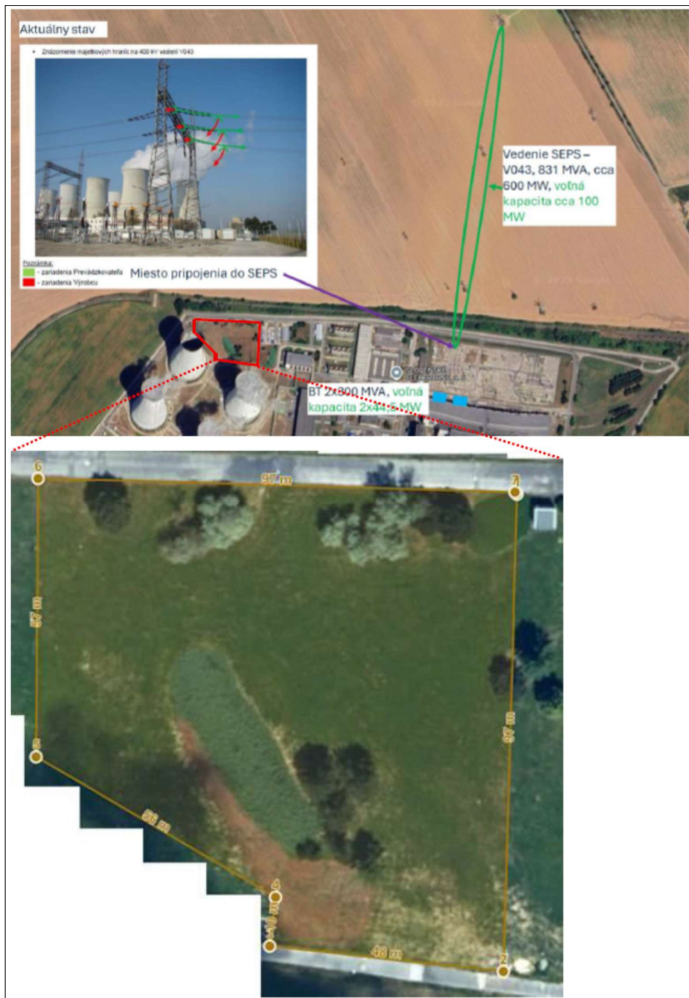
Obrázok č.1: Pozemok určený pre výstavbu batériového úložiska
