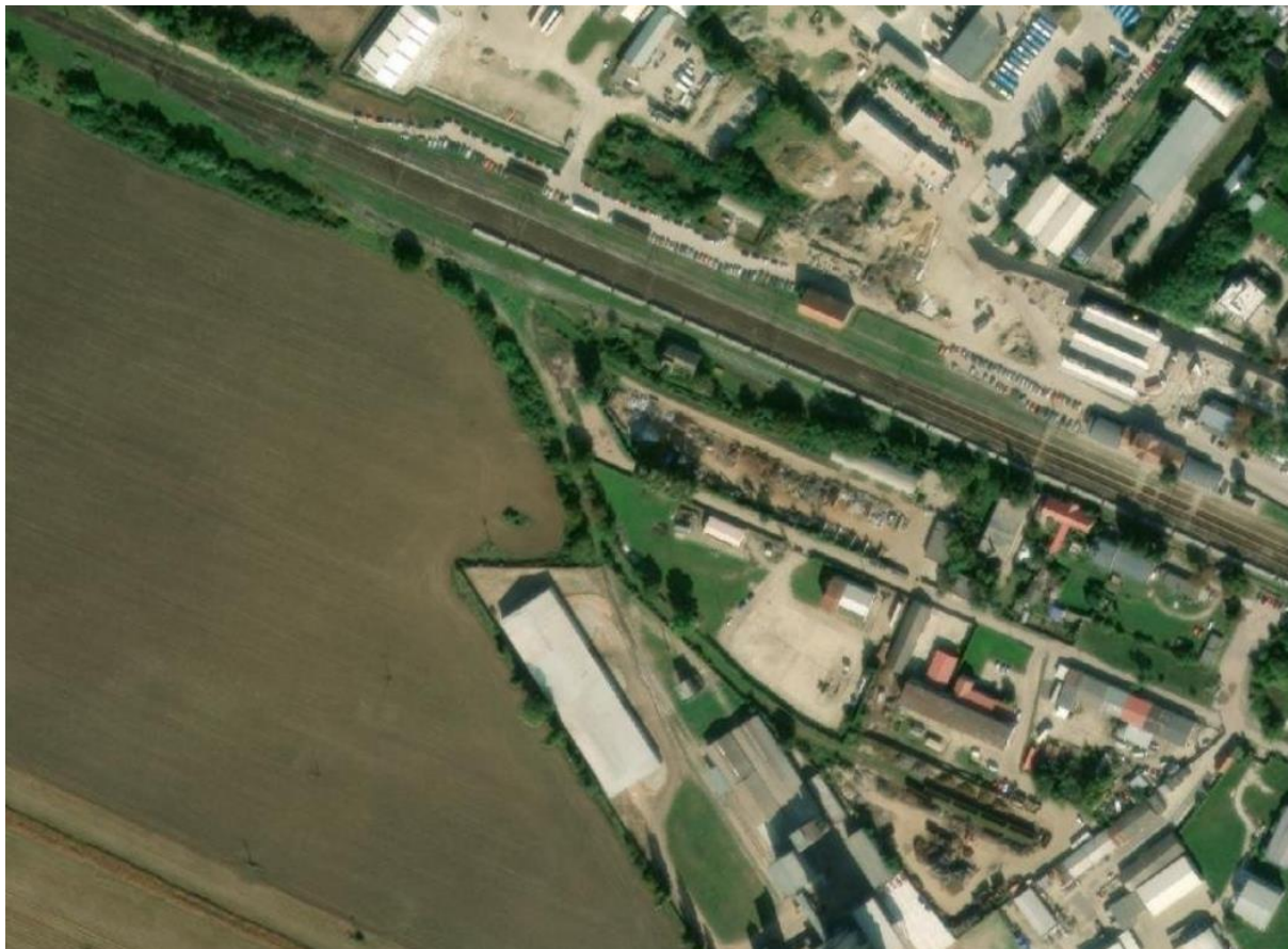
Obrázok 2 Napájací uzol železničnej vlečky na železničnú trať
