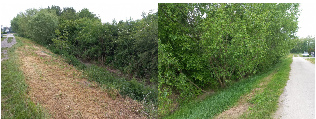
Obr. č. 2: Stav vegetácie na brehoch kanála Manivier na začiatku intravilánu obce Žlkovce - cca 200-300m od miesta plánovaného výustného objektu (22.05.2025)
