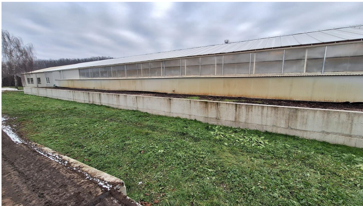
Obr. 2 Biofilter na strane fermentačnej haly (stav bez prestrešenia)
