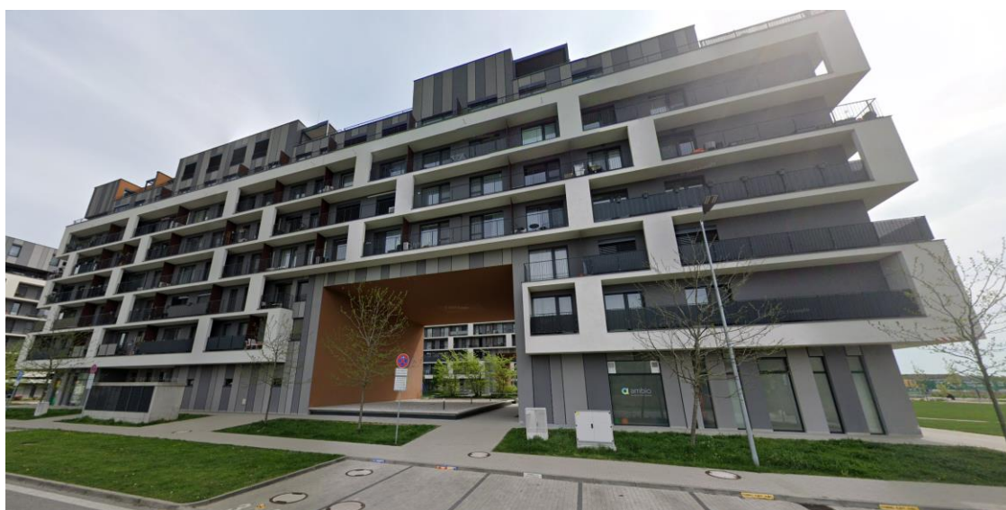
Obr. 11 Bytový dom B.III.
