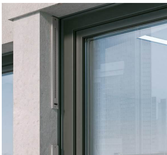
Obr. 31 příklady aktivních vetracích prvků určených na montáž do obvodového pláště (Siegenia, Systemair, Elektrodesign, Lunos, Dalap, Zender, Schüco, Siegenenia )
