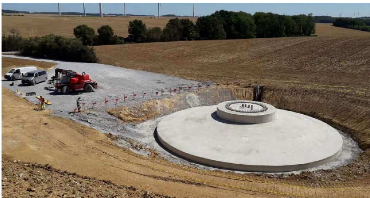
Obr. 20 Ukážka budovania základov pre veternú turbínu
