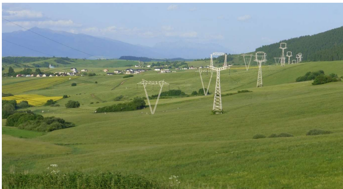
Obr. 7: Trasovanie koridoru vedení V406 a V461 cez zosuvné územie nad prameňom Zúbra (k.ú. Liptovská Štiavnica)
