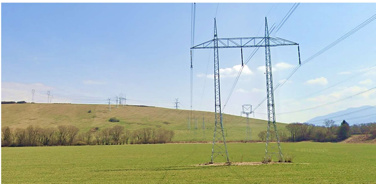
Lokalita Kľačianka, k.ú. Zemianska Ľubňa, Kráľovská Ľubňa. Pohľad z cesty III/2325 na koniec úseku inovácie vedenia V406. Posledný pôvodný stožiar sa nachádza v zalomení vedenia doľava vo svahu za potokom. V pozadí spoločný koridor 400 kV vedení v priestore nad ESt Liptovská Mara.
