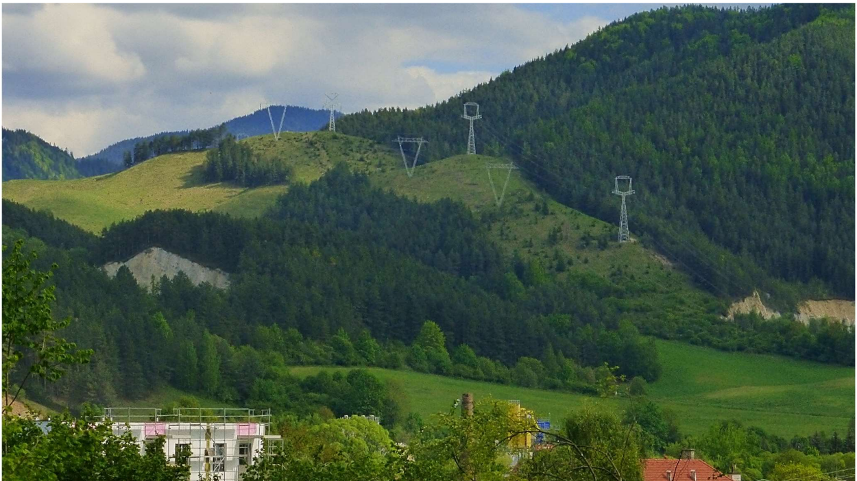
Lokalita Vyše skál, k.ú. Ružomberok, 6-2025. Pohľad na začiatočný úsek spoločného koridoru vedení V406 (ľavé so stožiarmi „Kotvené V“) a V461 (pravé so stožiarmi „Mačka“) vo svahovitom teréne nad lomami, resp. pod masívom Borovniska (vpravo).
