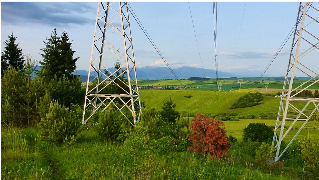
Lokalita Skalka, k.ú. Liptovské Sliače, 6-2025. Pohľad na spoločný koridor vedení V406 a V461 vstupujúci cez chrbát pahorkatiny (v strede) do okresu LM. V pozadí vľavo Partizánska Ľupča.
