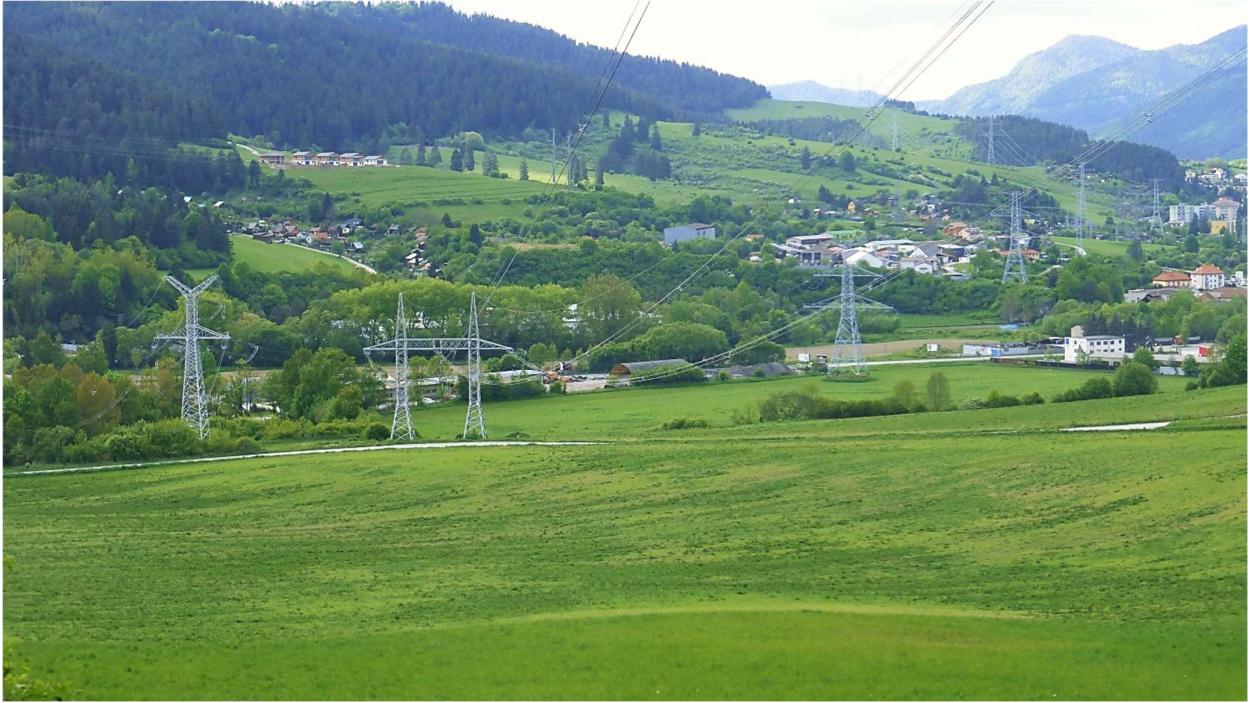
Lokalita Vyše skál, k.ú. Ružomberok, 6-2025. Pohľad na začiatočný bod budúceho inovovaného úseku V406 z cesty Biely Potok - Biela Púť - Ludrová. V strede prvý pôvodný stožiar vedenia V406 typu Portál, vedľa neho stožiar typu Mačka paralelného vedenia V461. Za nimi spoločný stožiar 2x400 kV oboch vedení. V pozadí J okraj Ružomberka.
