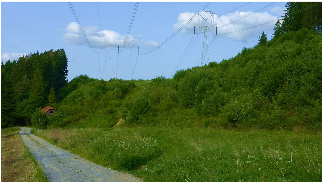
Lokalita Komornícka dol. - ústie, k.ú. Liptovská Štiavnica, 6-2025. Časť lesného úseku spoločného koridoru vedení V406 a V461 s udržiavaným ochranným pásmom. Vľavo objekt horárne v ochrannom pásme.
