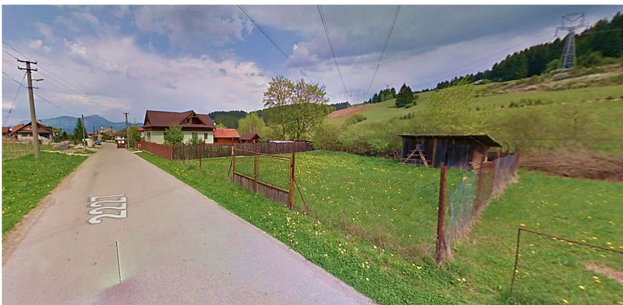
Obec Ludrová - južný okraj, k.ú. Ludrová. Prechod samostatnej línie vedenia V406 cez zastavané územie. V strede dom č.s. 162 v ochrannom pásme. Vpravo samostatná línia V461.
