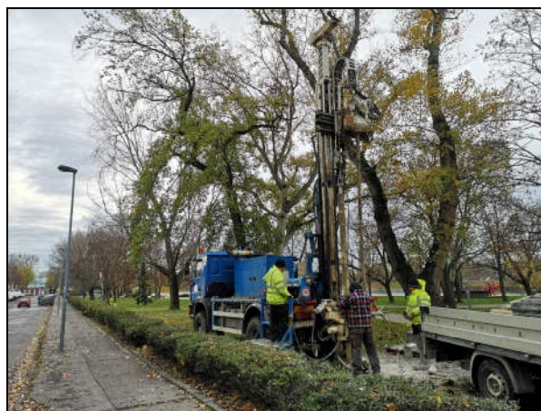
Obr.11b: Vrtne práce – prieskumná sonda ST-4 (situovaná v blízkosti Štrkoveckého jazera)
