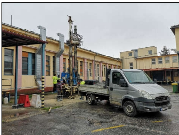
Obr.11a: Vrtne práce – prieskumná sonda ST-5 (situovaná v areáli čistiarní)
