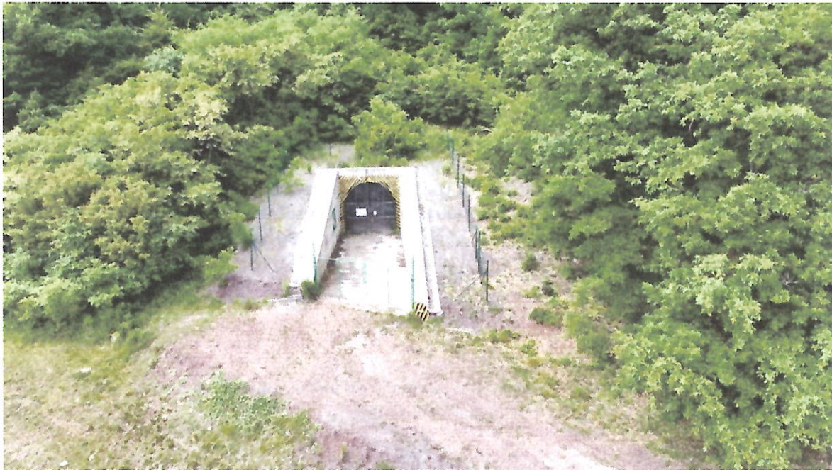
Obrázok č. 4 Pohľad na portál vetracej a únikovej štôľne
