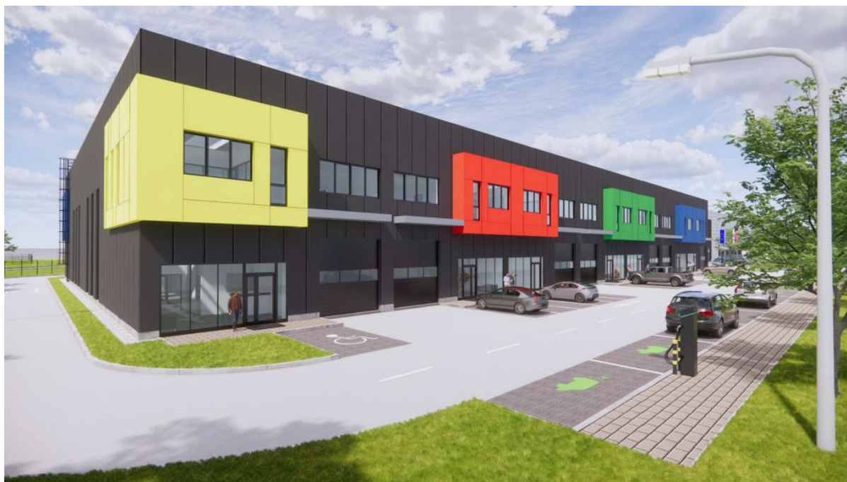
SV pohľad na SO A02 a JV pohľad na SO B03 – Logisticko-výrobný park Zeleneč
