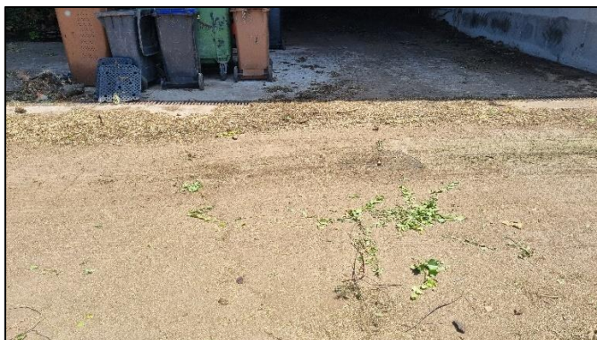
Akumulačná nádrž AN3 pri krytej hale (6m 3 )
