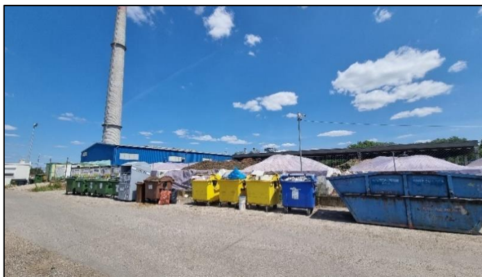
Pohľad do areálu kompostárne z váhy na prístupovej areálovej ceste
