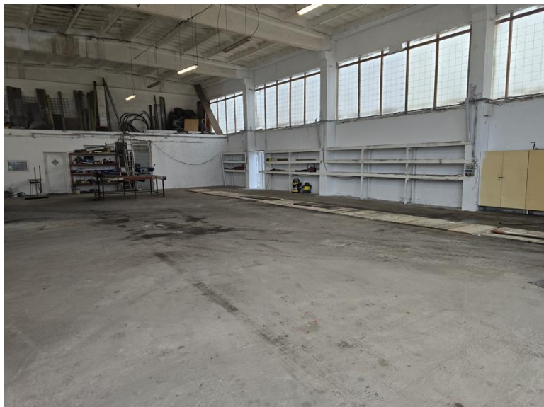
Obr.č.3 – pohľad na časť „výrobno-skladovej haly“ – betónová podlaha, opatrená náterom voči chemickým vplyvom
