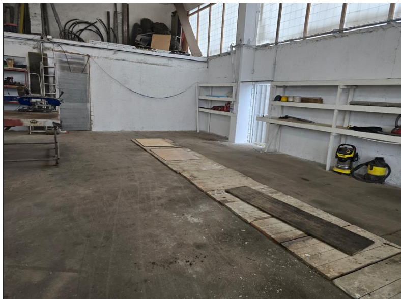
Obr.č.1 – pohľad na časť „výrobno-skladovej haly“, kde bude zriadené miesto na zber starých vozidiel – určené parkovisko, v počte 4 kusy. Toho času zakrytá časť podlahy je záchytná havarijná nepriepustná nádrž, ktorá bude slúžiť na prípadné odkvapy znečisťujúcich látok.
