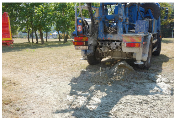
Obr. č. 2d: Sonda VS-2 zlikvidovaná spätným záhozom
