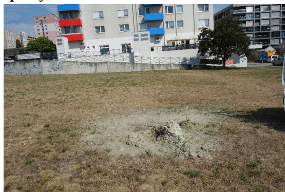
Obr. č. 1d: Sonda VS-1 zlikvidovaná spätným záhozom
