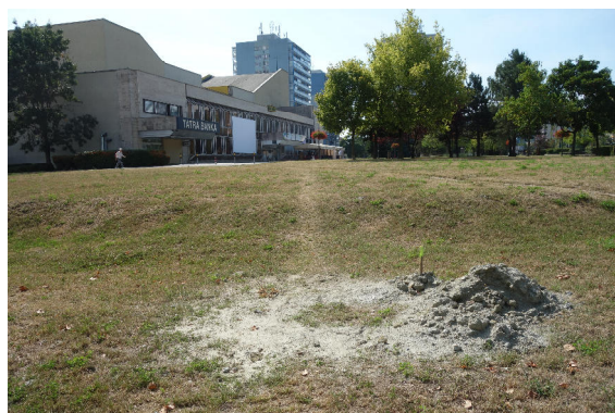
Obr. č. 3d: Sonda VS-3 zlikvidovaná spätným záhozom
