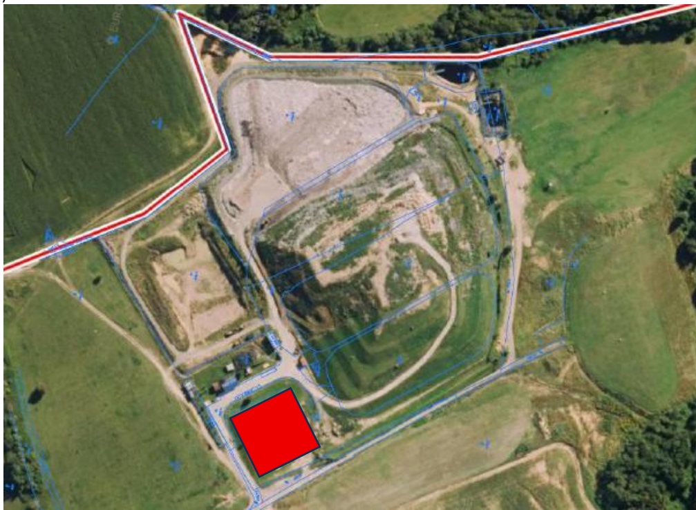
Obrázok 3 Plocha na úpravu odpadu pred skládkovaním
