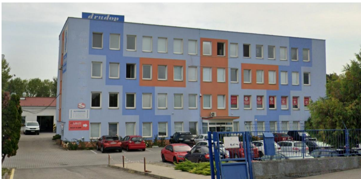
Obr. 11 Nebytová budova - DRUDOP (zdroj googlemaps.com)
