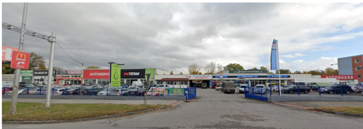
Obr. 12 Nebytové budovy - obchodné prevádzky pozdĺž ulice Bajkalská (zdroj googlemaps.com)
