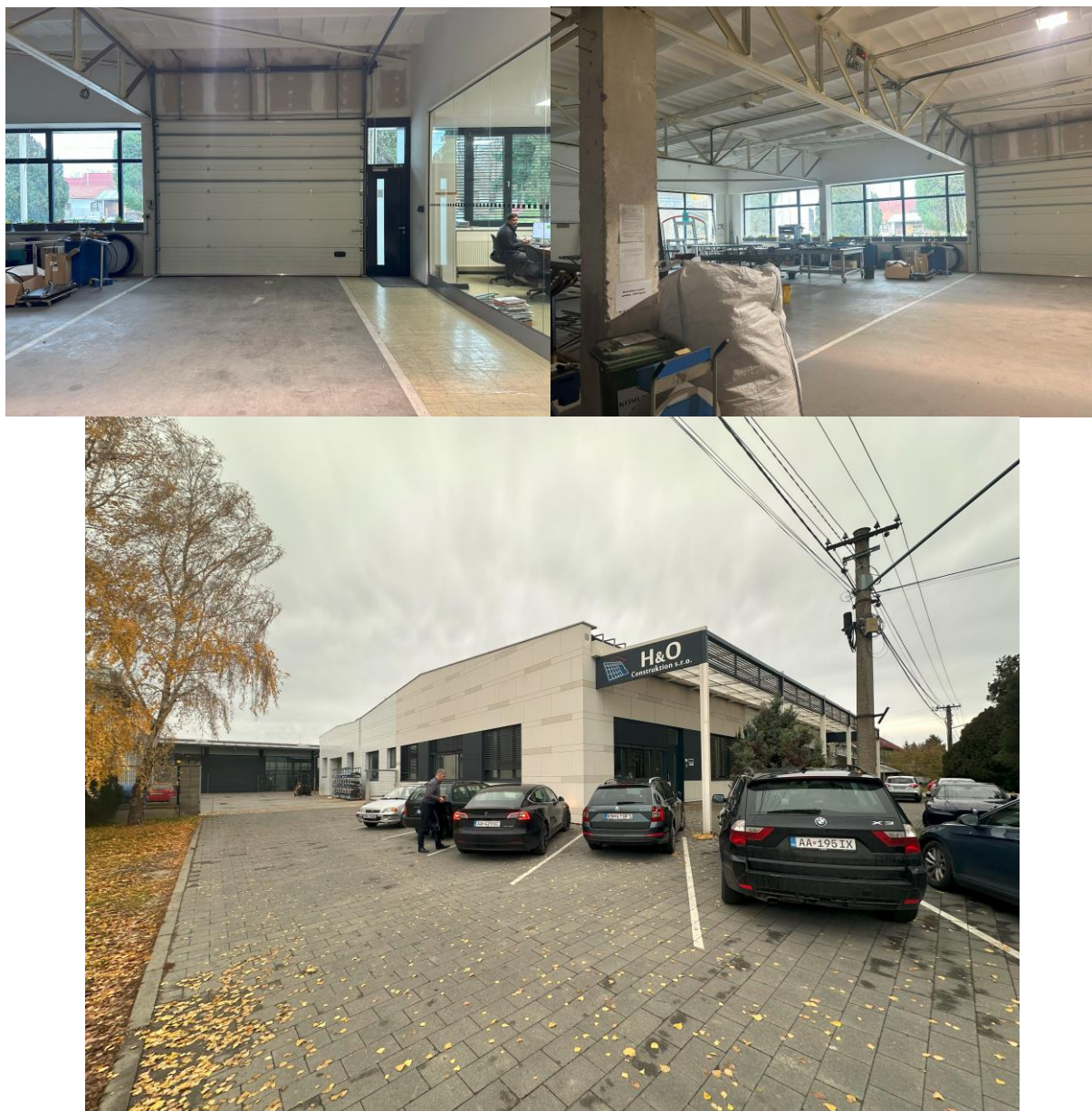
Obr. 2.4 Pohľad na administratívnu a montážnu časť
