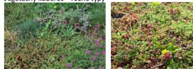
Vegetačná strecha založená výsevom – zmes pre strechu s fotovoltikou obsahuje 32 rastlinných druhov alebo bylinná biodiverzitná zmes obsahuje 40 druhov suchovzdorných bylín vhodných pre extrémne podmienky.
