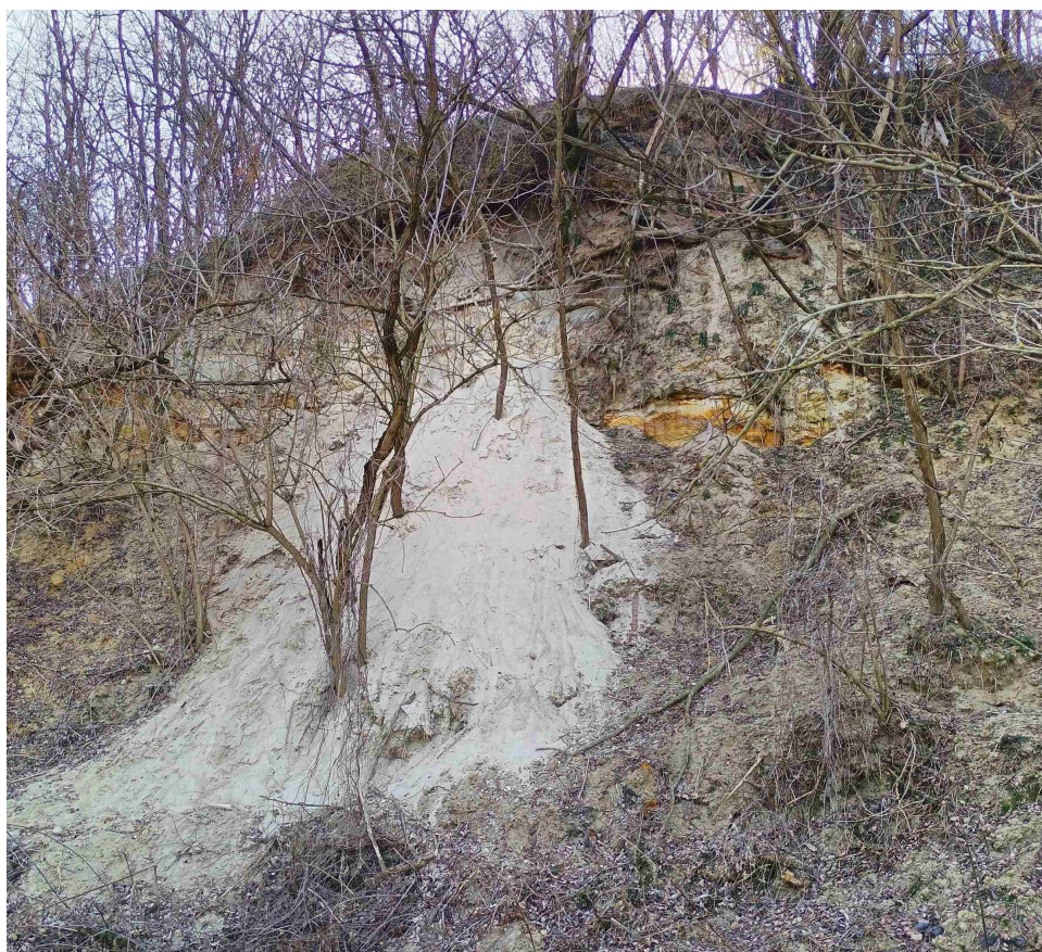
Foto č. 2 Severná stena svahu nad skládkou .
