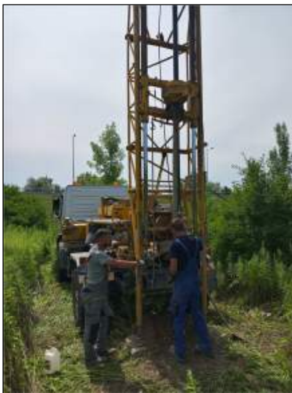
Obr. 6.1.1. Vrtná súprava UGB 50 M na vrte PS-2
