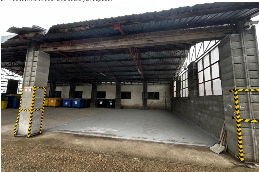
Obr. č. 5: Prístrešok na skladovanie ostatných odpadov
