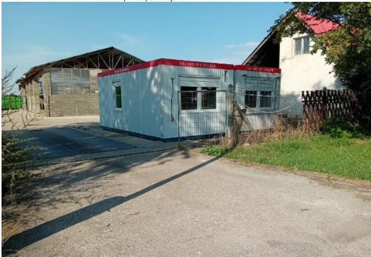
Obr. č. 4: Váha a administratívna budova pri vstupe do objektu
