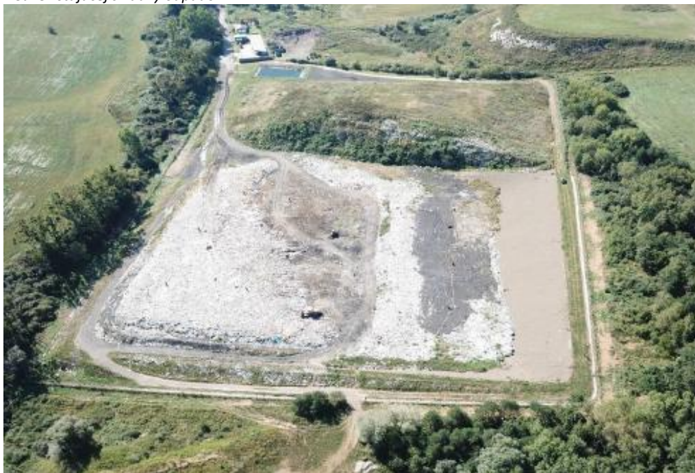
Obr. č.2: Areál existujúcej skládky odpadov
