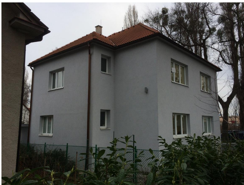
Obr. 20 - Foto rodinného domu na Valchárskej ulici č. 3 - 1375/3
