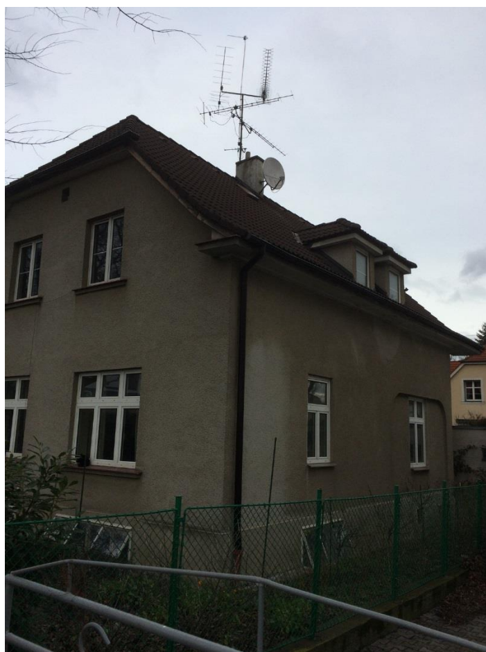
Obr. 19 - Foto rodinného domu na Plátenickej ulici č. 16 - 1370/16
