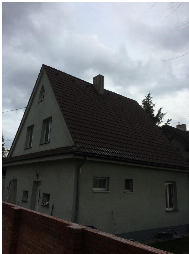
Obr. 16 - Foto rodinného domu na Plátenickej ulici č. 18 - 1371/18
