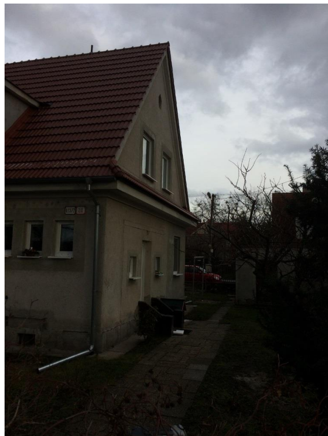
Obr. 15 - Foto rodinného domu na Plátenickej ulici č. 20 - 1372/20
