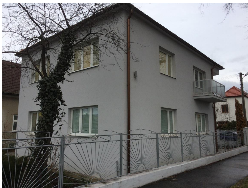
Obr. 21 - Foto rodinného domu na Valchárskej ulici č. 3 - 1375/3
