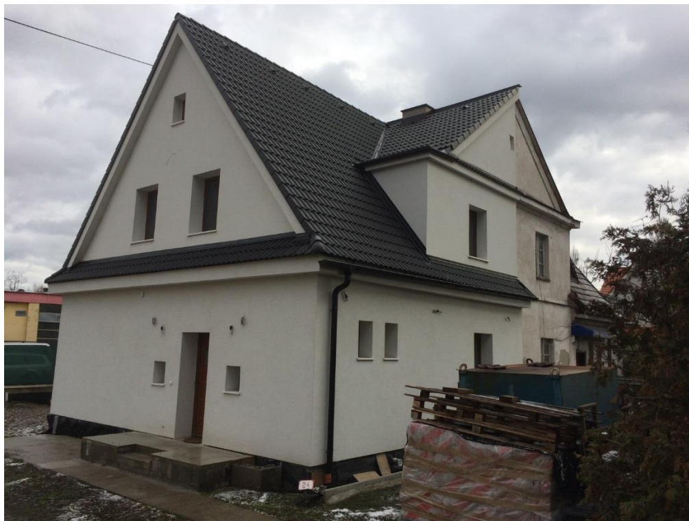
Obr. 12 - Foto rodinného domu na Plátenickej ulici č. 24 - 1374/24
