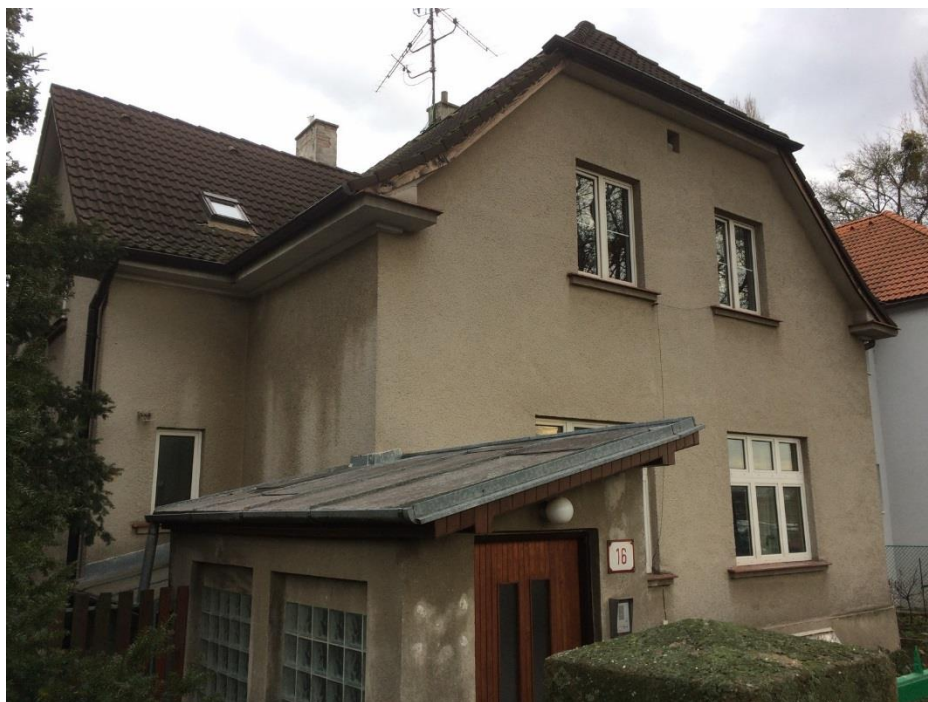
Obr. 18 - Foto rodinného domu na Plátenickej ulici č. 16 - 1370/16
