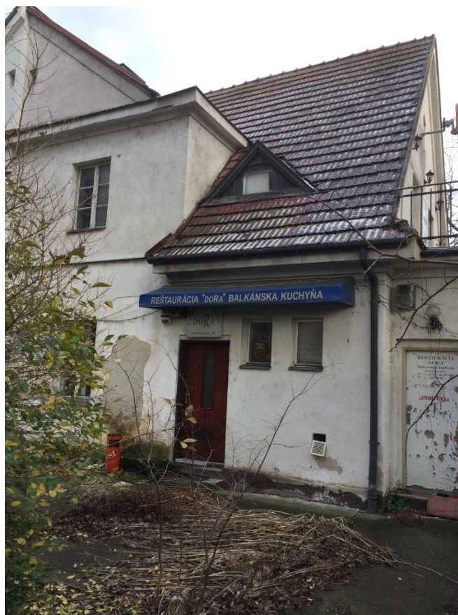
Obr. 13 - Foto rodinného domu na Plátenickej ulici č. 22 - 1373/22
