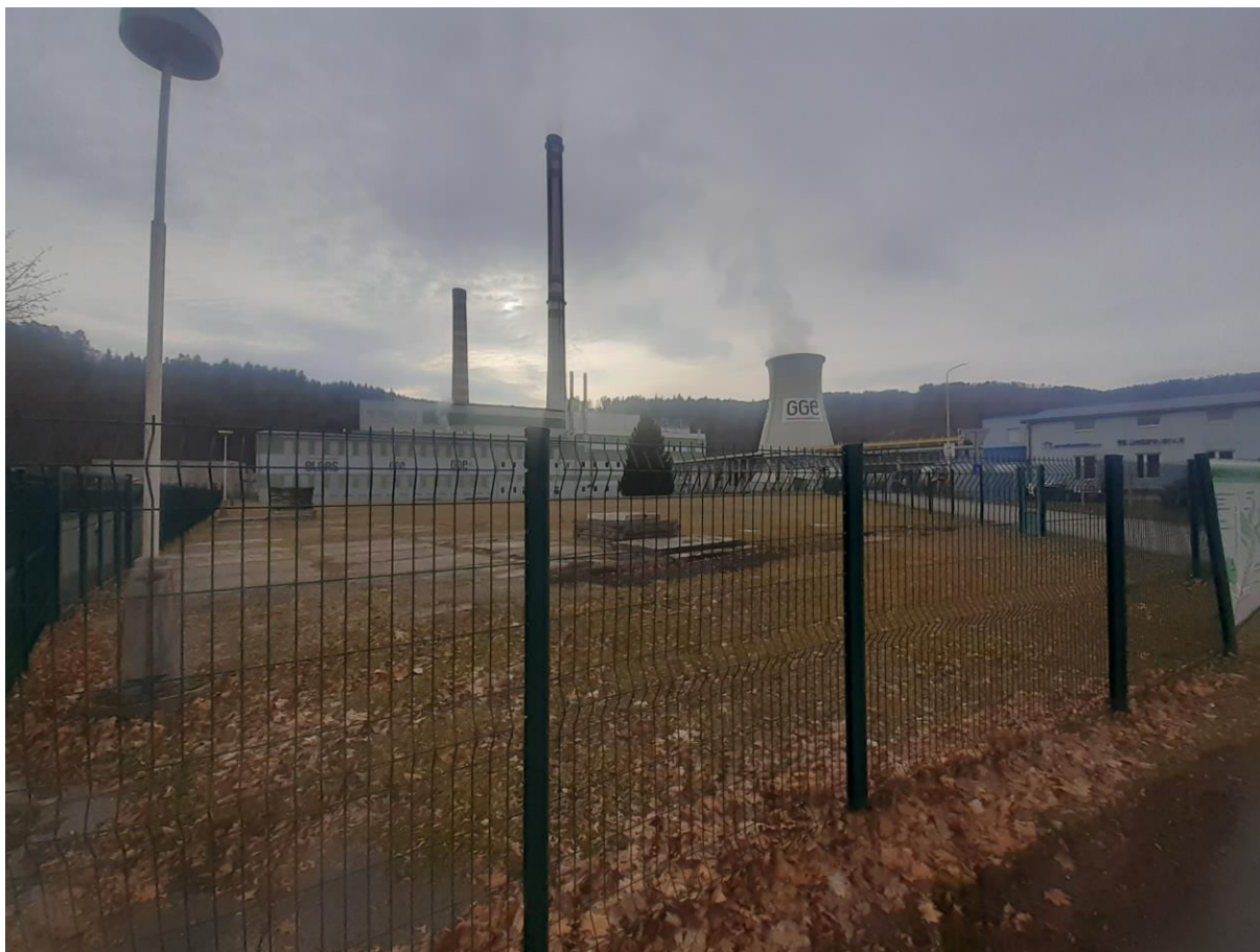
Obr. 2 Miesto pre umiestnenie stacionárneho batériového systému
