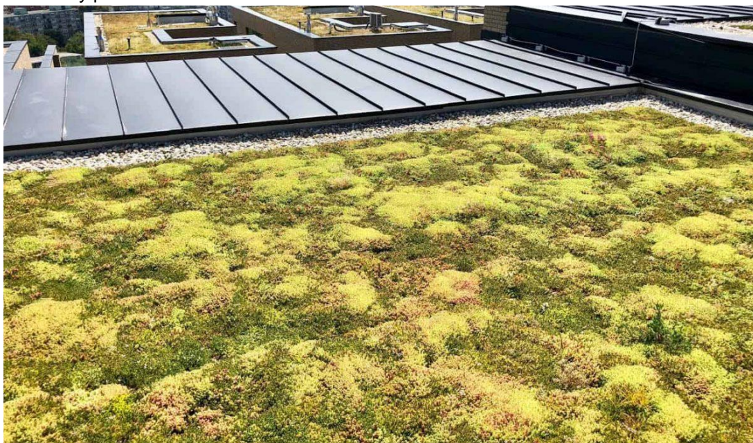
Obr.: Ilustračný pohľad na extenzívnu strešnú zeleň
