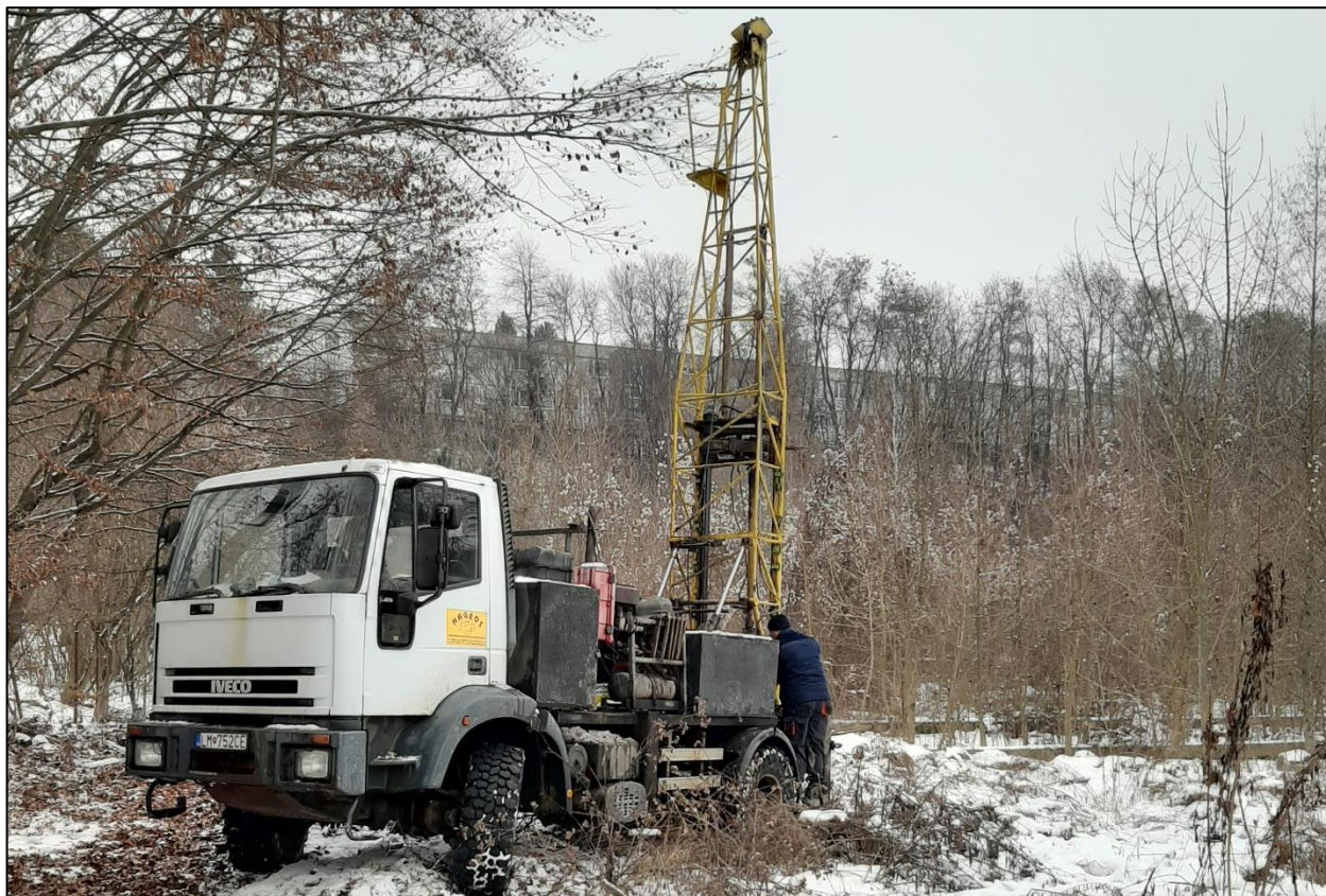
Realizácia vrtu BZ-3 vrtnou súpravou UGB 50M
