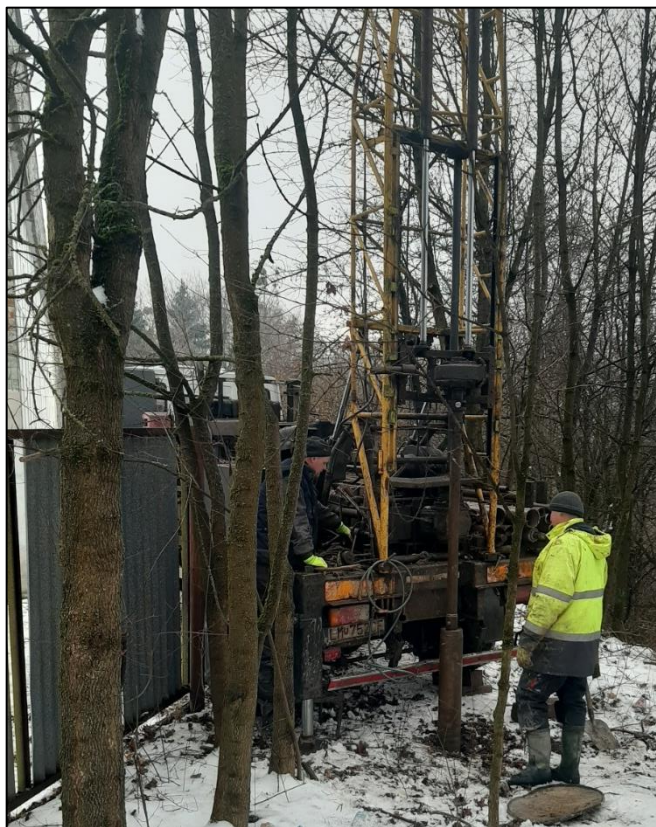
Realizácia vrtu BZ-7 vrtnou súpravou UGB 50M
