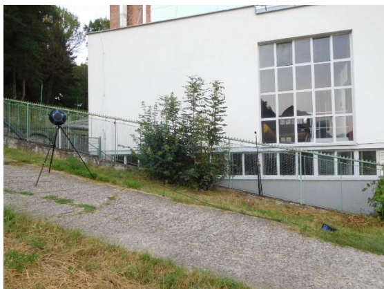
Obr. P2.4 Meranie rozdielu hladín akustického tlaku na južnej fasáde budovy kotolne K-2
