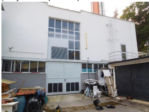
Obr. P2.3 Meranie rozdielu hladín akustického tlaku na severnej fasáde budovy kotolne K-2
