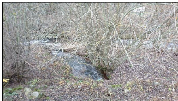
Obrázok 6: Vyústenie odtoku z priepadov vodojemu
