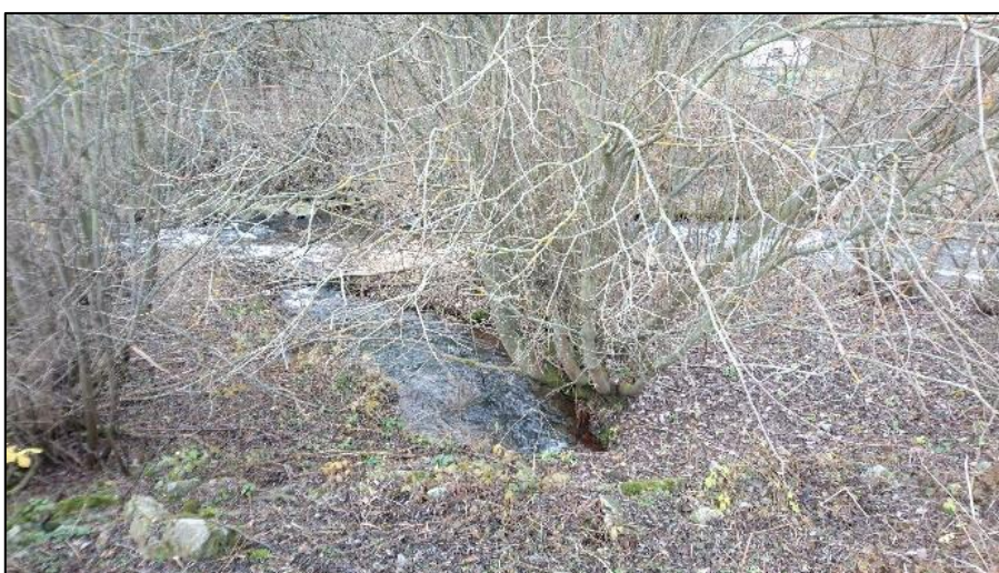
Obrázok 7: Vyústenie odtoku z priepadu vodojemu
