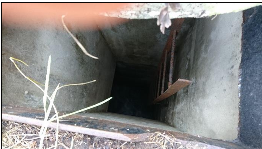
Obrázok 5: Pohľad do kontrolnej šachty
