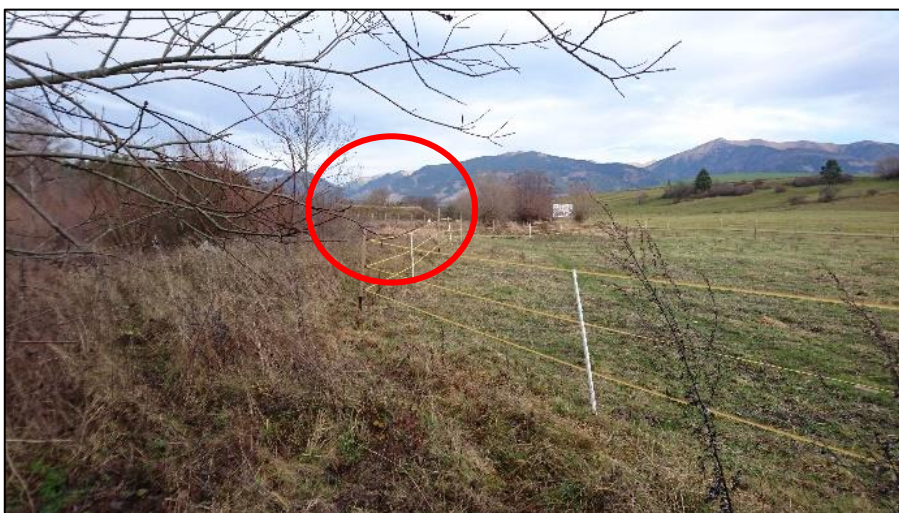
Obrázok 6: Pohľad na vodojem z miesta vyústenia odtoku z priepadu vodojemu
