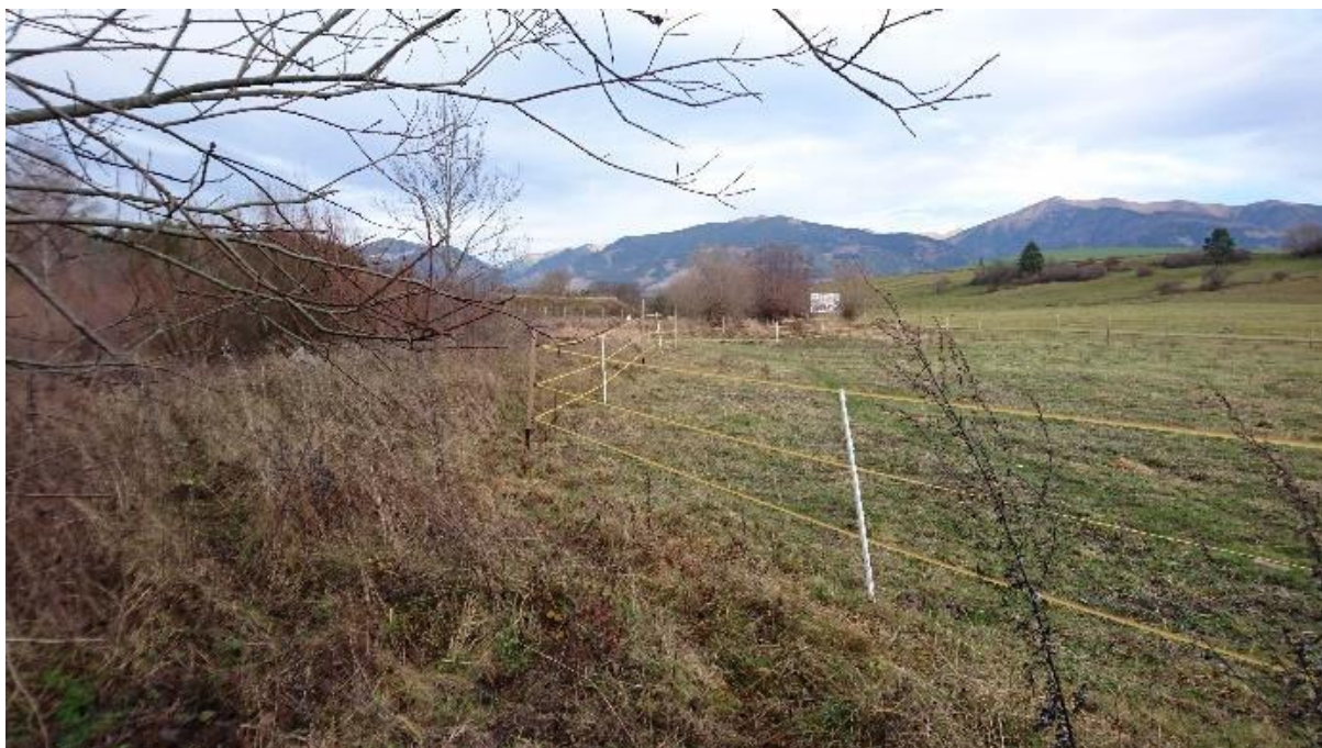
Obrázok 9: Pohľad na vodojem z miesta vyústenia odtoku z priepadu vodojemu
