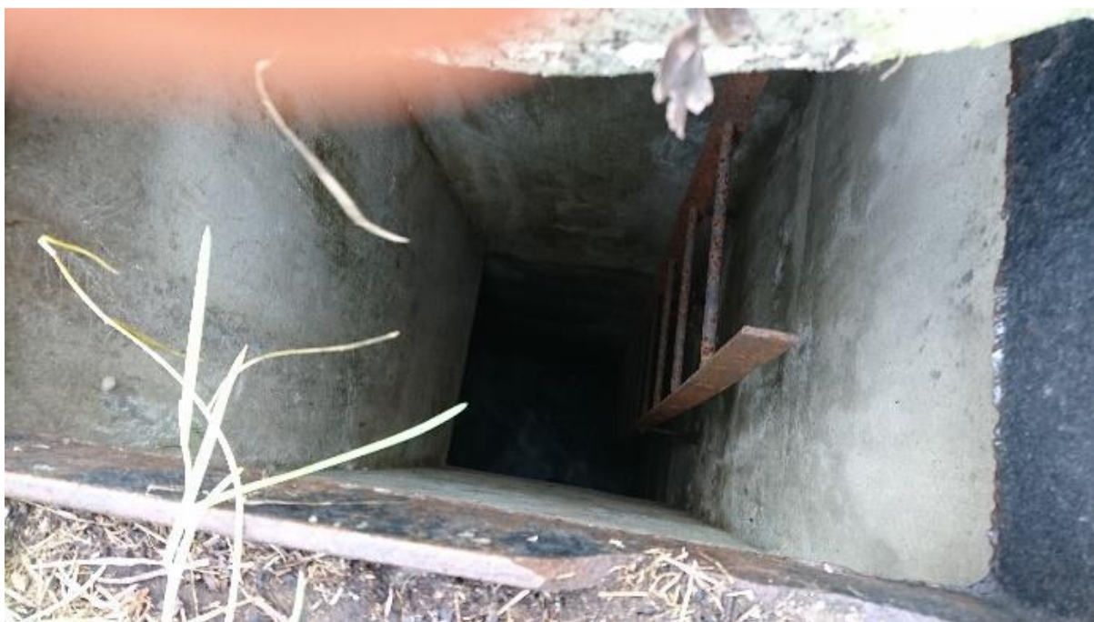
Obrázok 8: Pohľad do kontrolnej šachty
