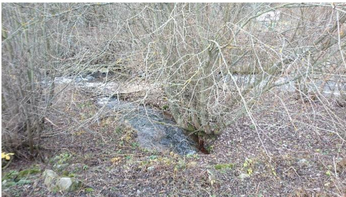
Obrázok 10: Vyústenie odtoku z priepadu vodojemu
