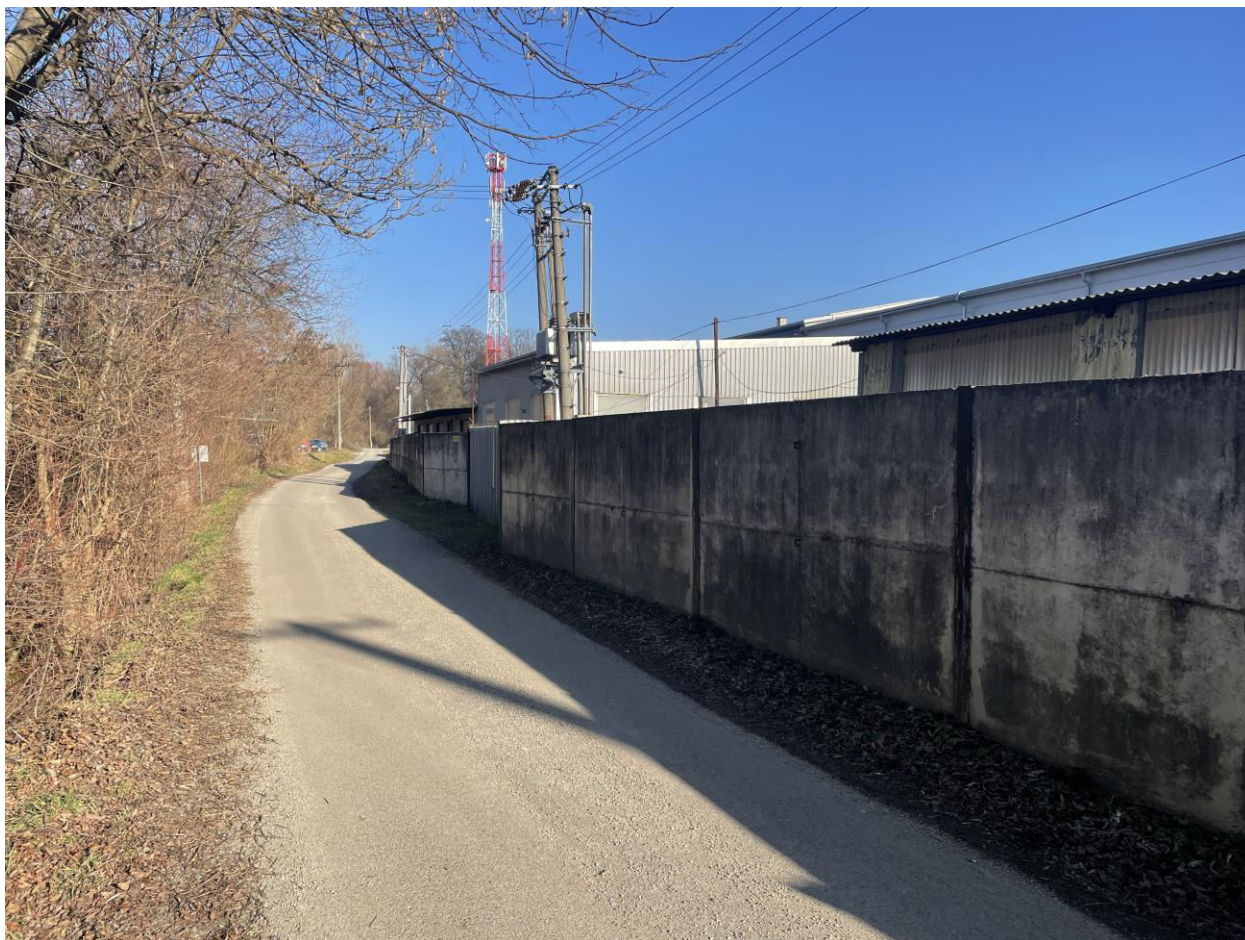
Foto 1 Západná časť jestvujúceho oplotenia, ktoré bude prebudované na protipovodňový oporný múr.
