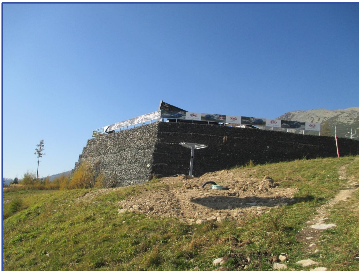
Obrázok 7: Údolná stanica 4-CLF Čučoriedky – variant 0 – oporný gabiónový múr Zdroj: HES – COMGEO, a.s.
