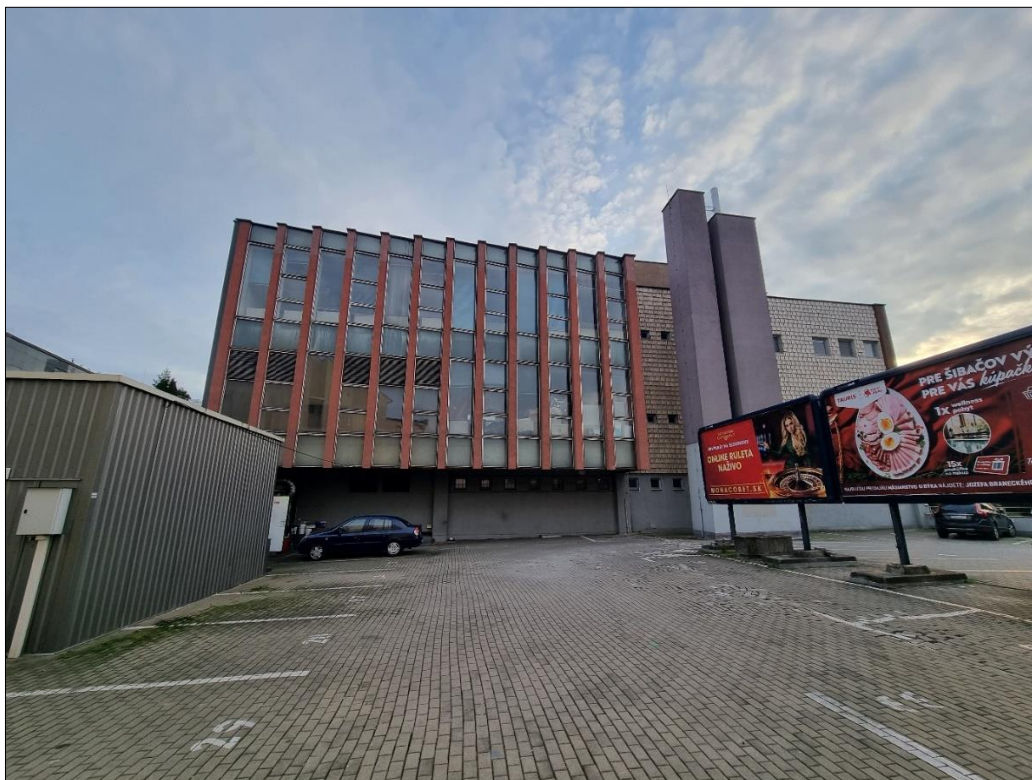
Severovýchodná časť objektu OD PRIOR s parkovacími a odstavnými plochami
