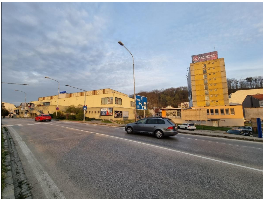
Pohľad na OD PRIOR od juhozápadu z Palackého ulice, vpravo susedný panelový obytný objekt
