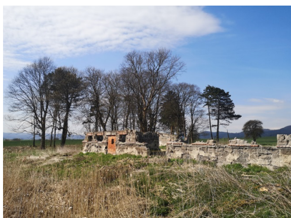
Obr. 6 – Pohľad na rozpadnuté objekty nachádzajúce sa na posudzovanej lokalite
