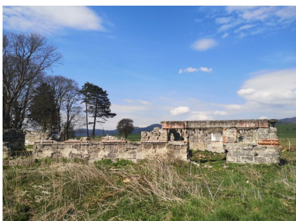
Obr. 5 – Pohľad na rozpadnuté objekty nachádzajúce sa na posudzovanej lokalite
