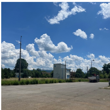
foto 4 trafostanica a spevnené plochy pred halou
