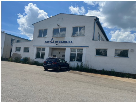
foto 1 - Pohľad na predmetnú halu
