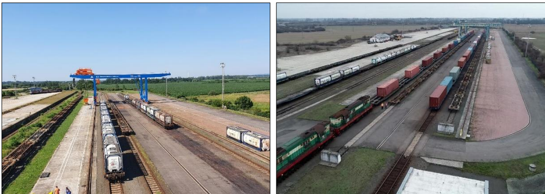
Obr. 3. Hlavný vstup do areálu s administratívnou budovou a vstupnou kontrolnou rampou (BTS, 2024), skladová hala – rampa (Reming Consult, a.s., 2024)
