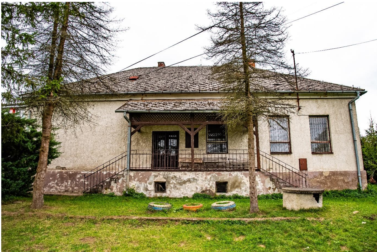
Obr. č. 6 Objekt bývalej Bosakovej školy
