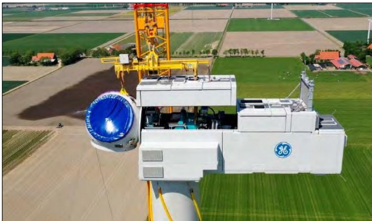
Obrázok 8: Výstavba veternej elektrárne – montáž gondoly
