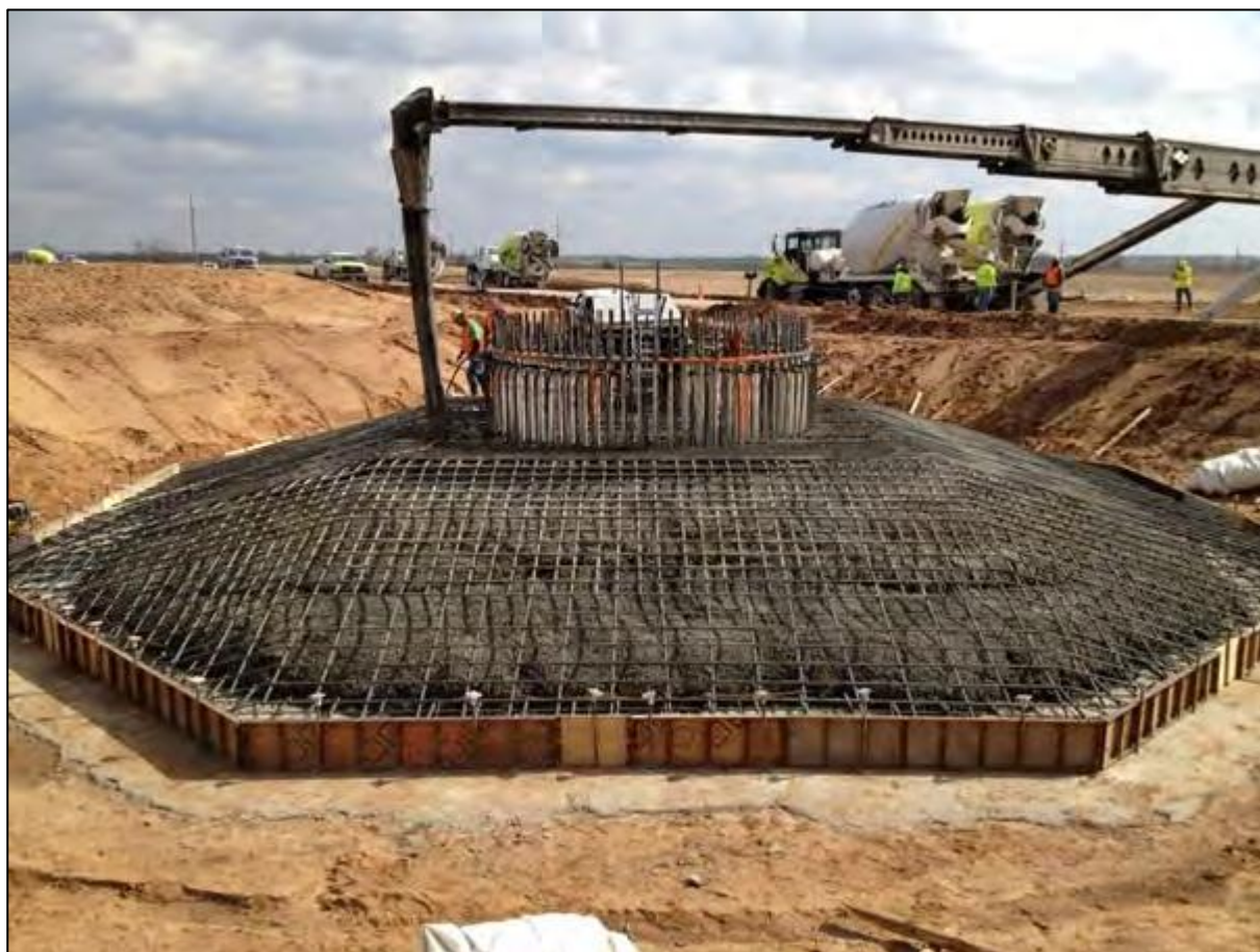
Obrázok 6: Teleso základov VtE z armovaného betónu
