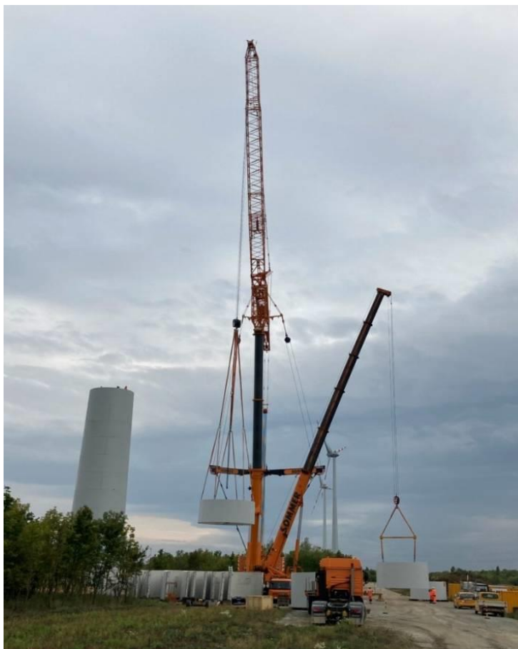
Obrázok 6 Príklad výstavby veternej elektrárne s použitím žeriavov
