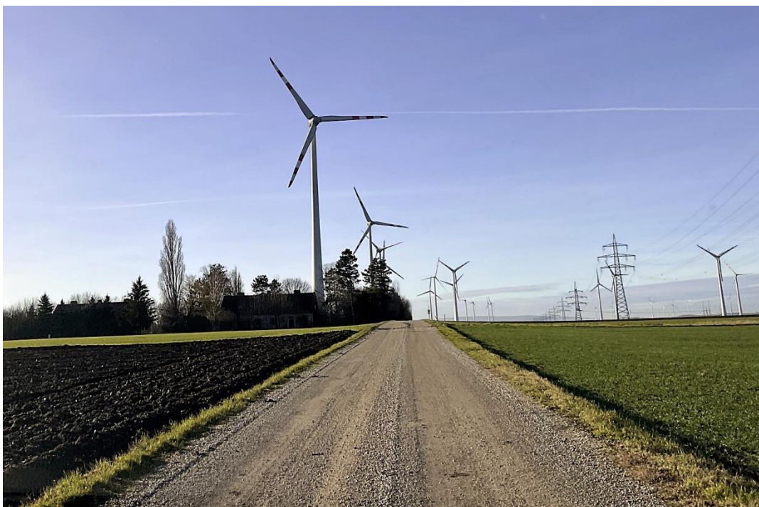
Obrázok 4 Príklad povrchovej úpravy poľných ciest, prístupových komunikácií a manipulačných plôch zo štrkodrvy
