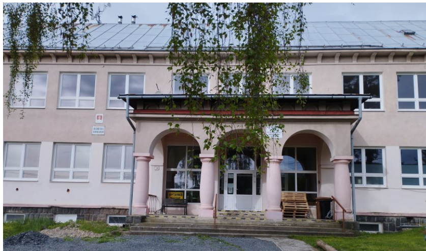
Telocvična, posilňovňa (Budova bábalej ZŠ)
